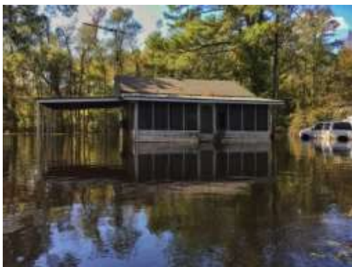
18 de octubre de 2016: Las aguas de inundación continuaron impactando en hogares en el condado de Marion 10 días después de que el huracán Matthew tocó tierra
